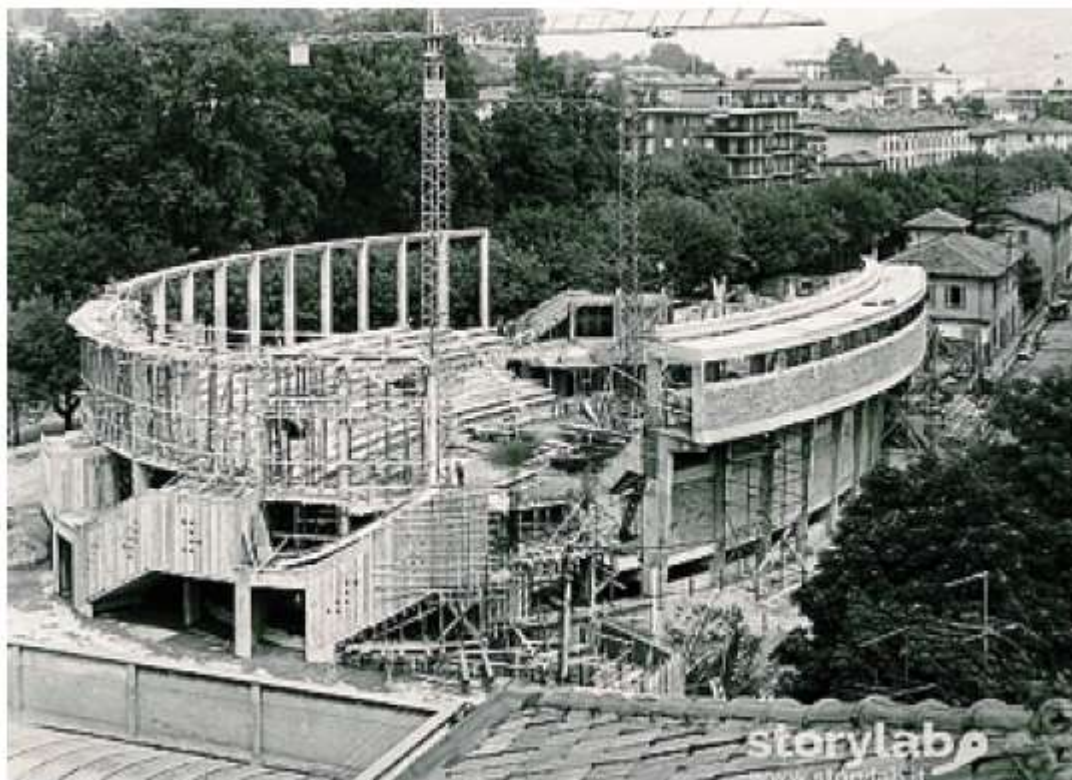
Il palazzetto dello sport durante il cantiere per la sua costruzione
