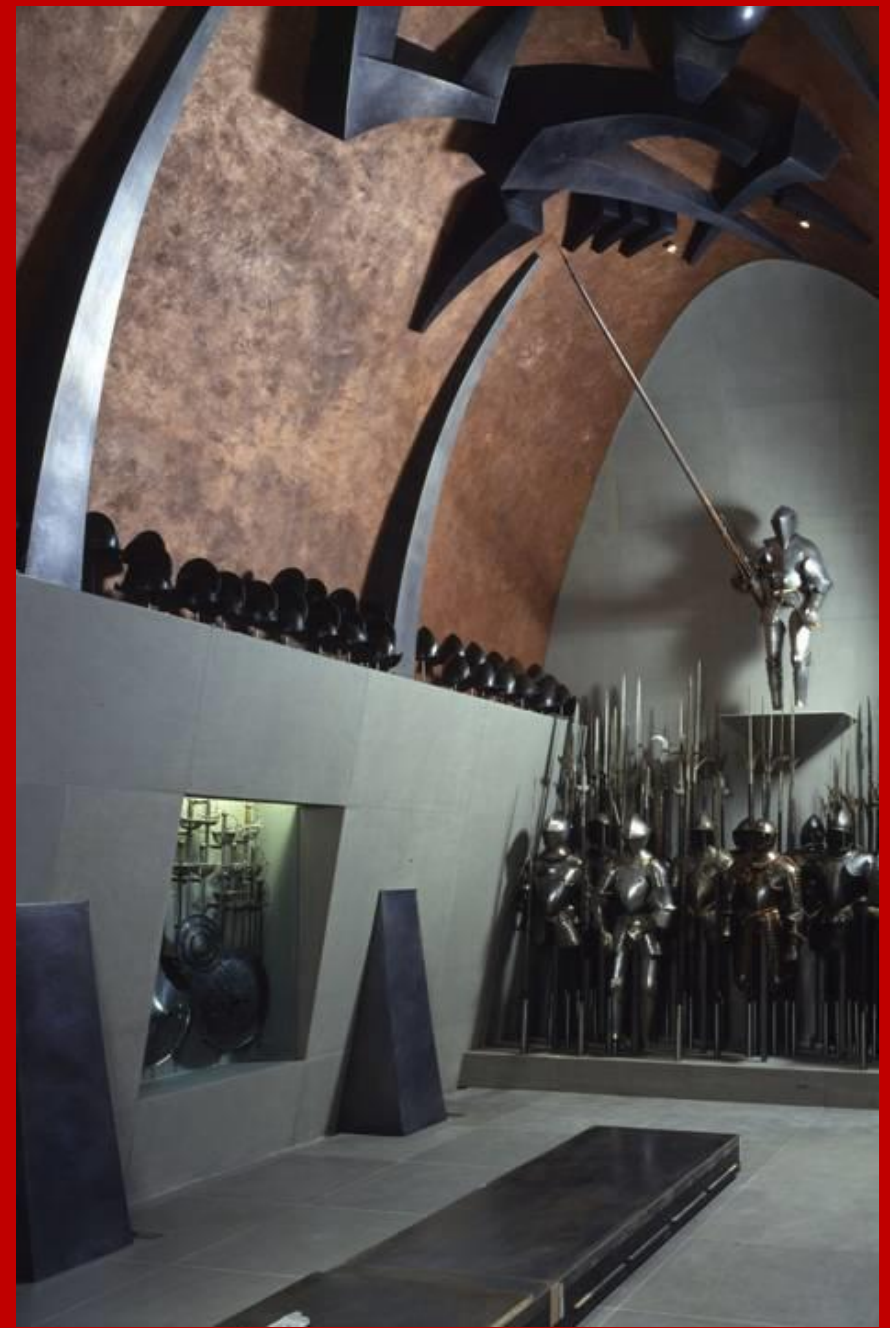
Solo tre materiali: pietra serena tagliata a sega (antiriflesso), piombo («contrafforti») e fibra di vetro (elementi del soffitto)
