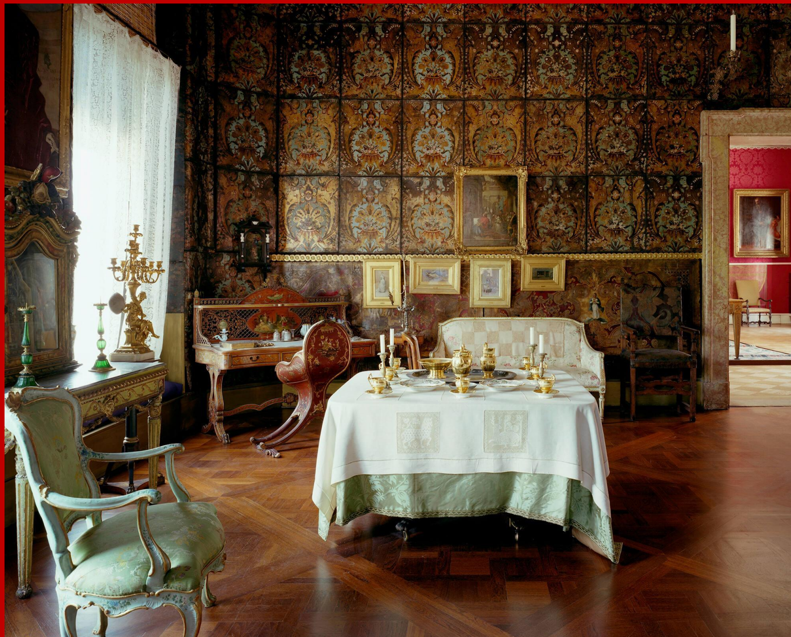
Dettaglio con rivestimento della parete a pannelli di pelle con foglia d'argento verniciata. Usato nel periodo barocco per creare un finto effetto a foglia d'oro
