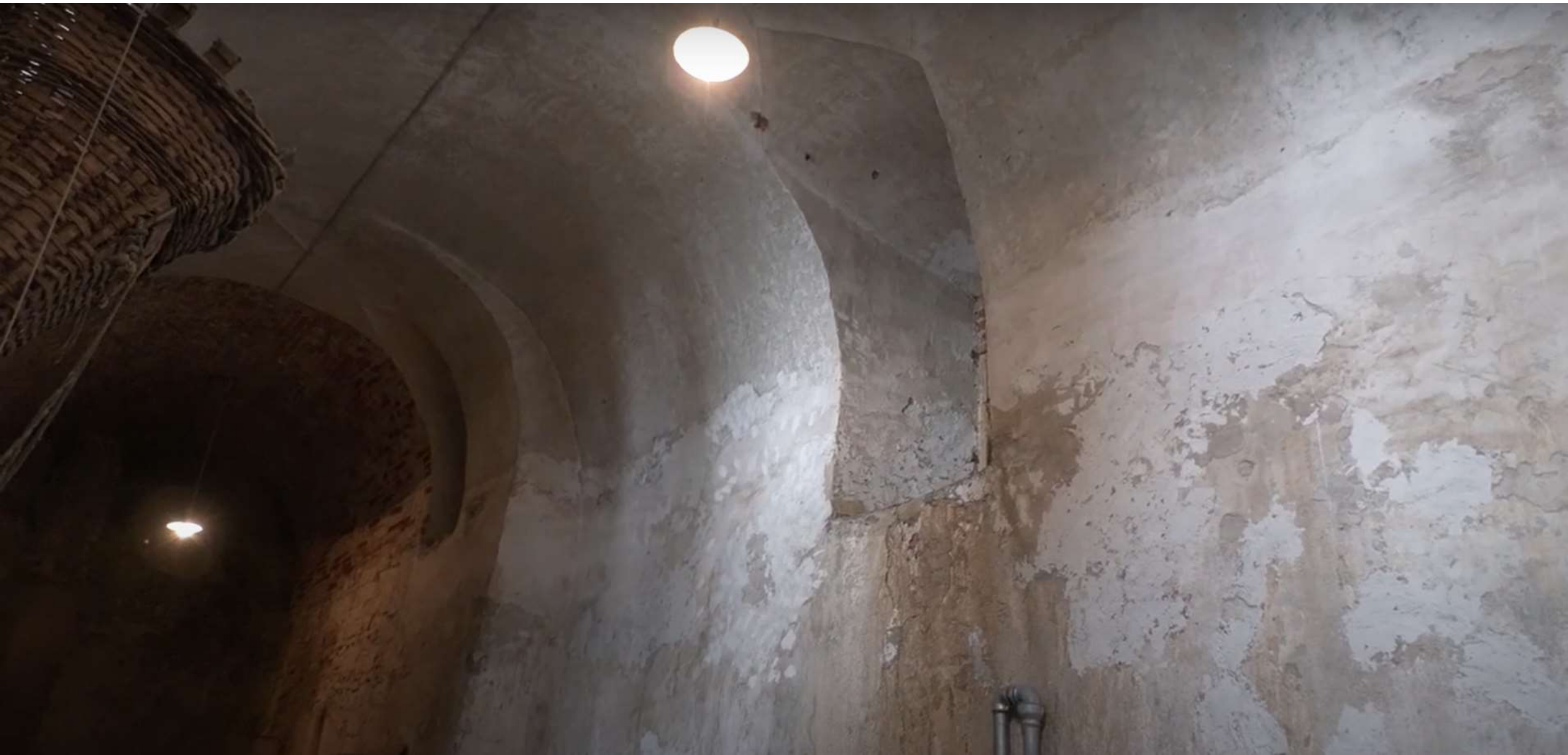
Il corridoio su cui affacciano le aperture delle cisterne
