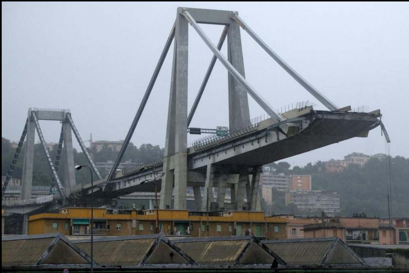
Viadotto Polcevera - Struttura in cemento armato precompresso
