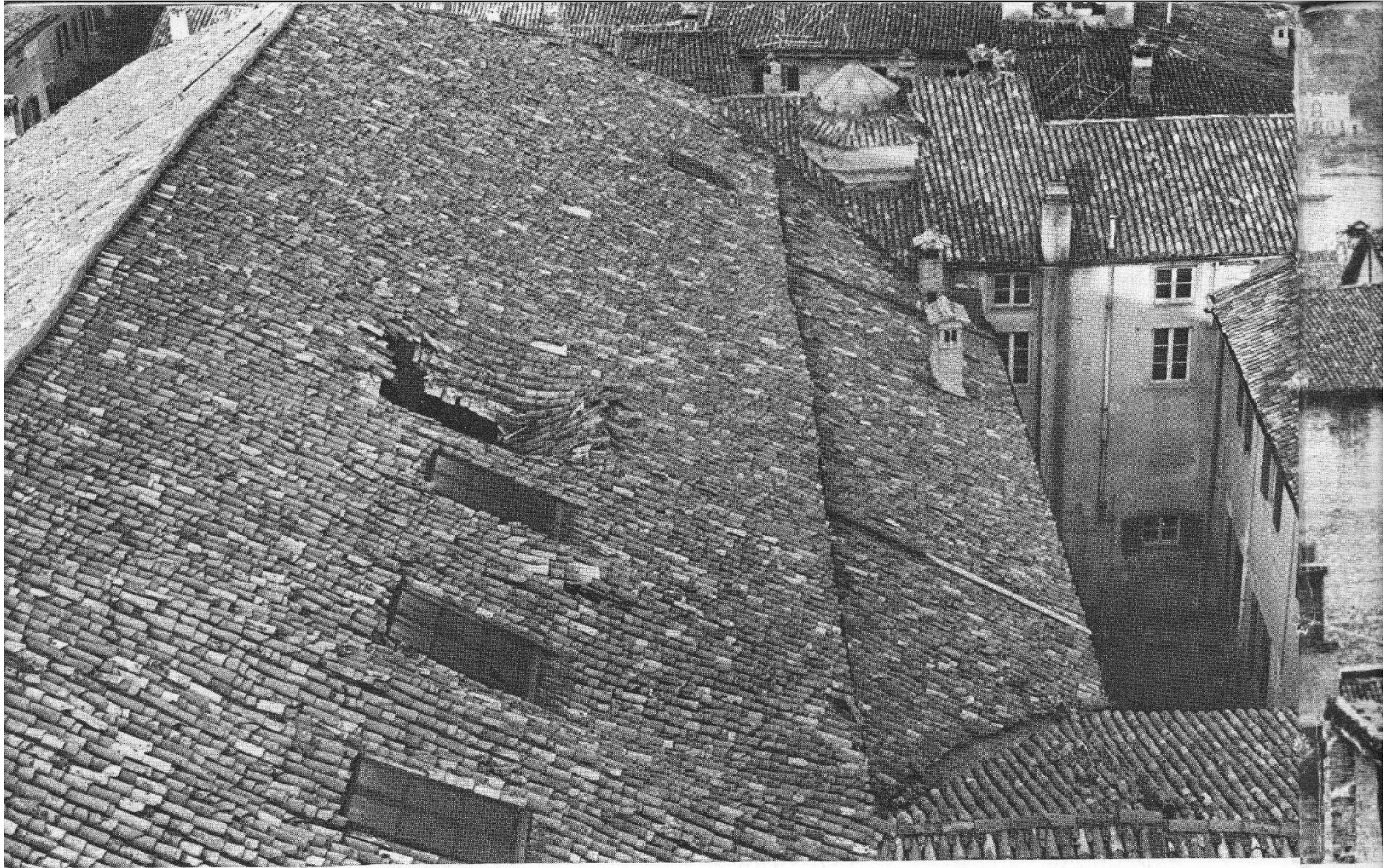
Teatro Sociale (Bergamo) - situazione del tetto 1970
